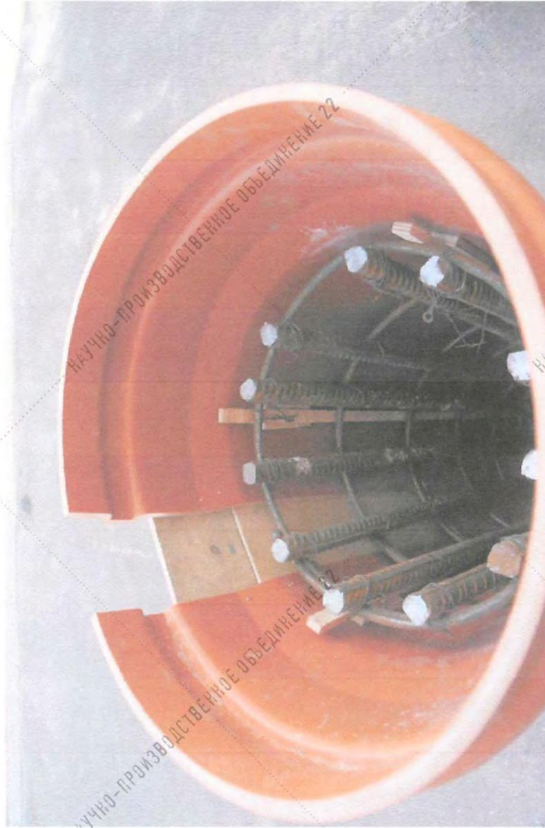
Рисунок 2.14 Арматурный каркас колонны БК\* Д-1, изготовленной в деревянной опалубке
