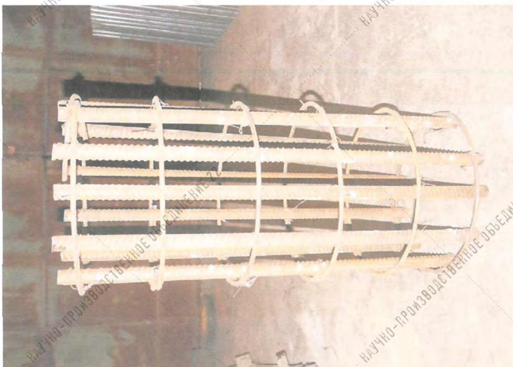
2.16 Арматурный каркас колонны БК\*С-1, изготовленной в несъемной опалубке
