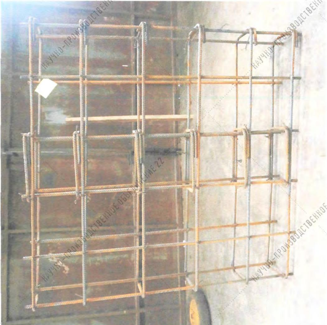
Рисунок 2.22 Общий вид арматурного каркаса фрагмента стеновой панели БСС-2 (БСС-3),
