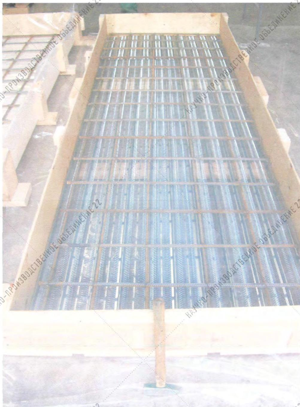
Рисунок 2.4 Общий вид опалубки плиты марки БПС с арматурным каркасом
