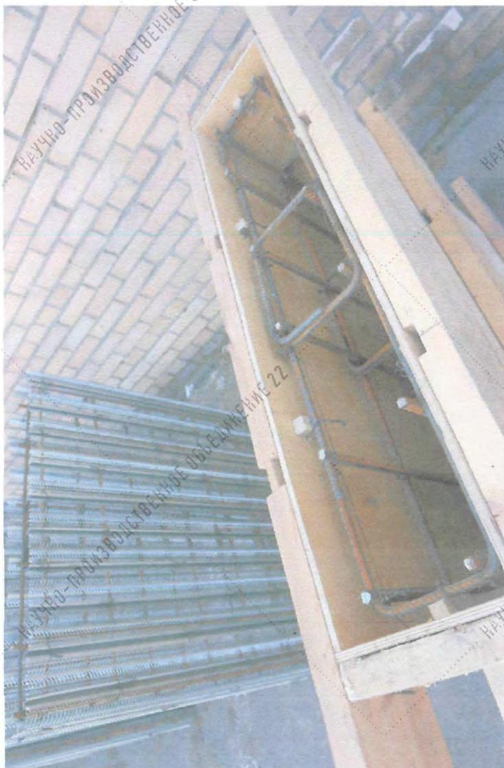
Рисунок 2.18 Арматурный каркас фрагмента стеновой панели
