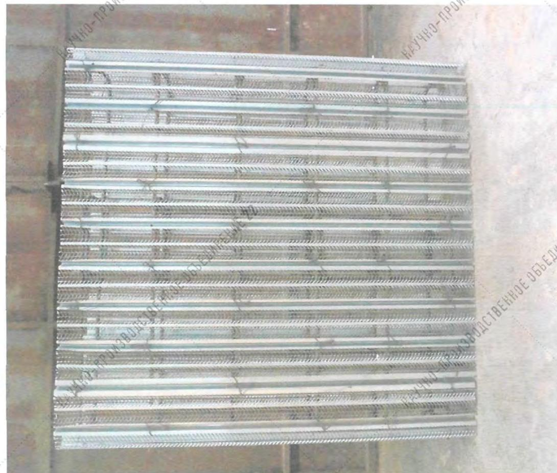
Рисунок 2.20 Фрагмент стеновой панели БСС-1, изготовленной в несъемной опалубке (без армирования)
