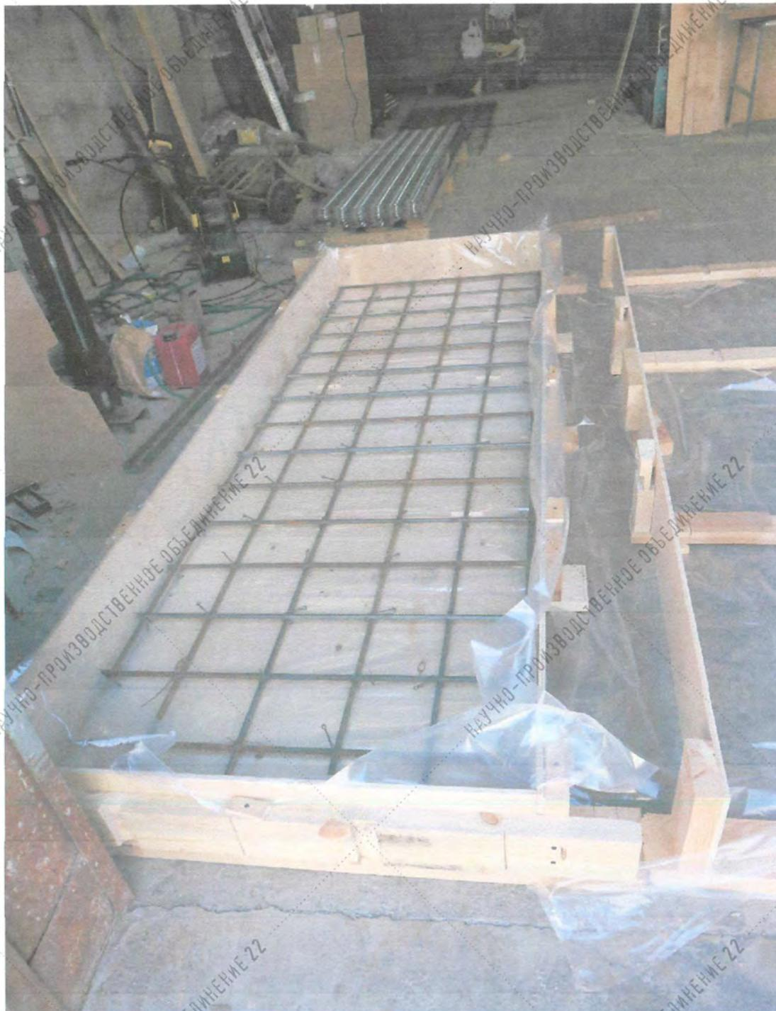
Рисунок 2.3 Общий вид опалубки плиты марки БПД с арматурным каркасом
